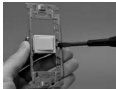
連用枠へ連用器具の取付け取り外し
