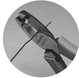
鉄バインド線の切断
